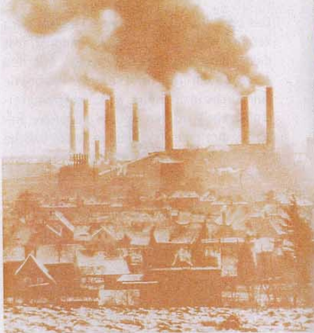
Das Kraftwerk im Jahre 1960
