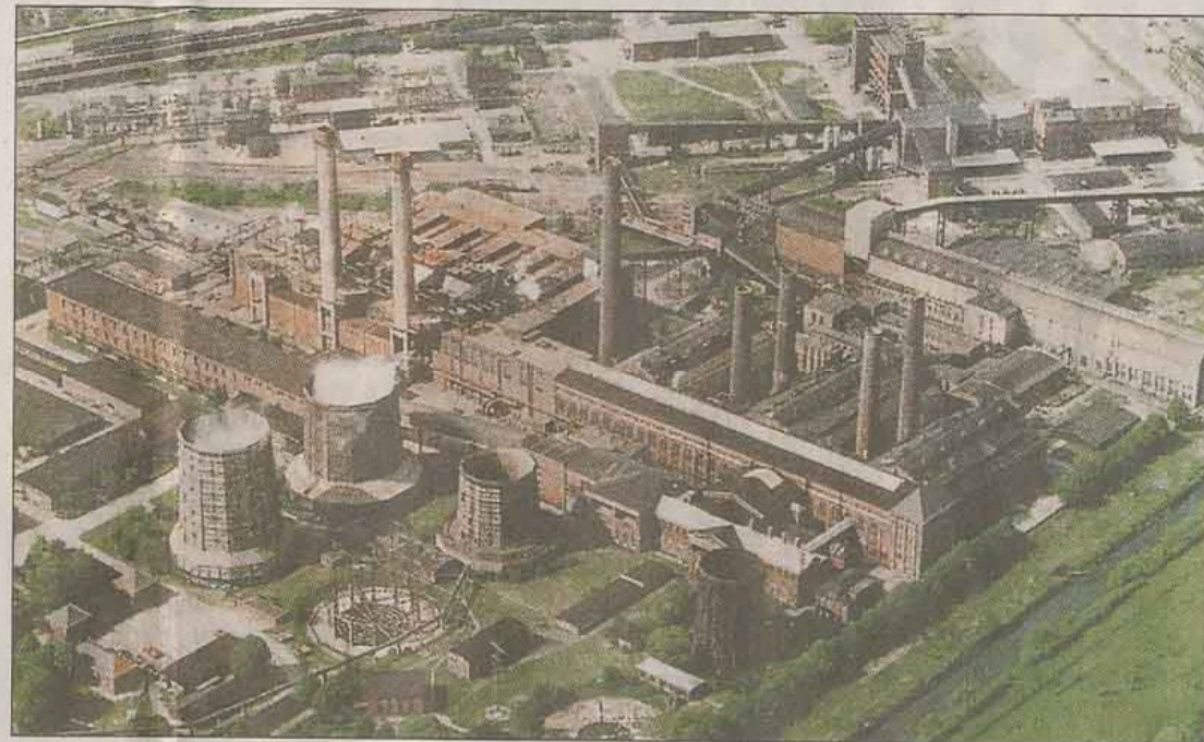
Dieses Luftbild des Kraftwerkes Hirschfelde stammt aus dem Jahr 1992. Ein großer Teil des früheren Betriebes ist seither zurückgebaut worden.
